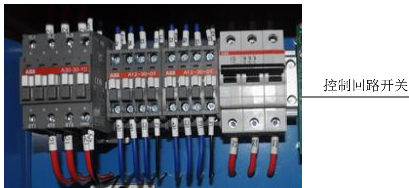
图6 电源主回路控制开关
